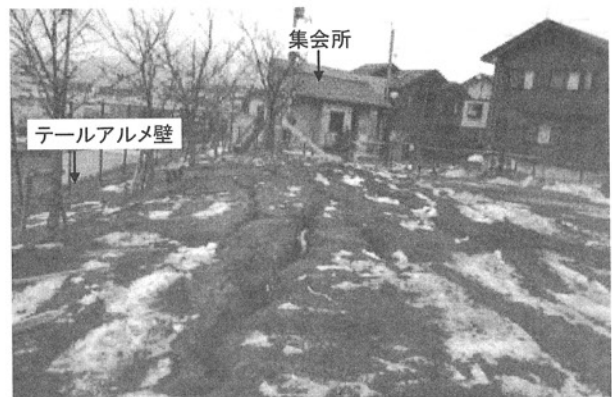
写真-3 上部公園内に発生した亀裂の状況
