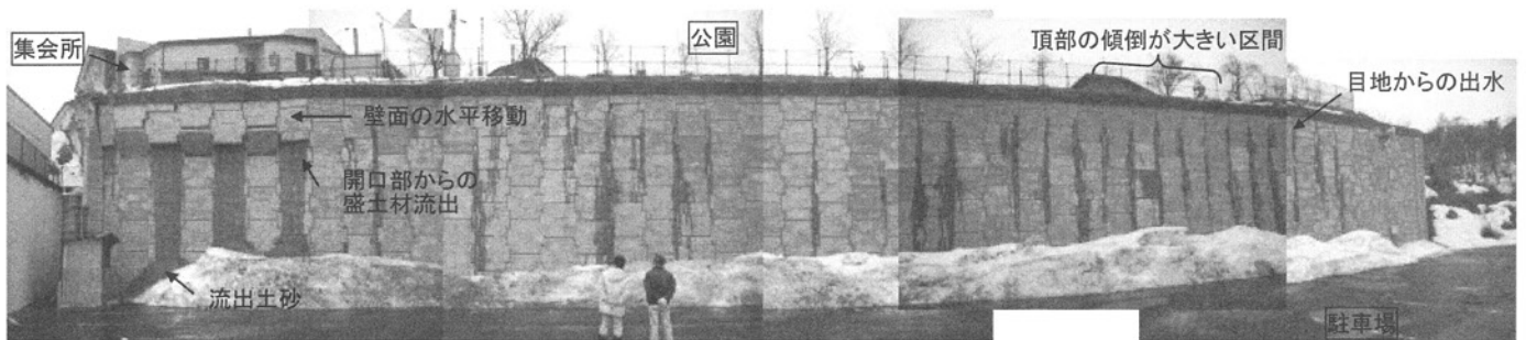
写真-4 被災擁壁全景
