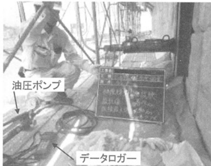
写真-8 健全度調査(引抜き試験)実施状況
