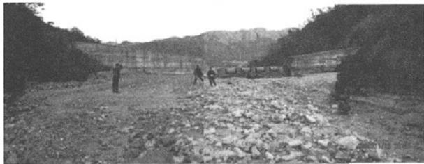
写真-1 上流砂防えん堤における堆砂状況
