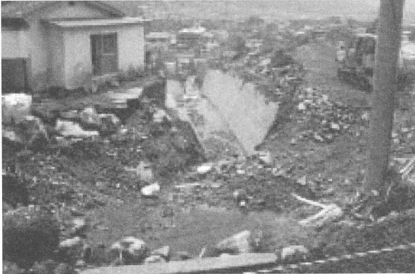
図-2 由布院湯布院町での災害状況
