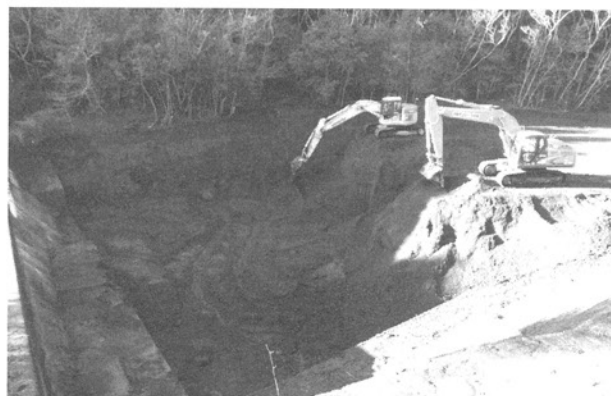
写真-4 緊急除石工実施状況(祓川第1砂防堰堤)
