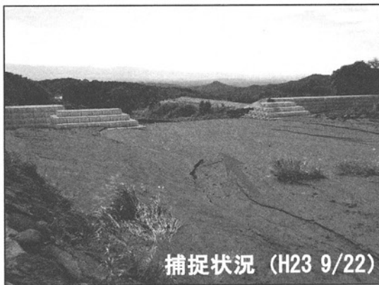
写真-6 除石後に流出土砂を捕捉した砂防堰堤 (荒川内上流砂防堰堤)
