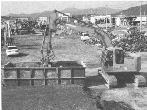
写真-10 気仙沼市における再資源化施工の様子
