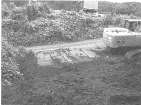
写真-4 ショベルによる改良土の転圧
