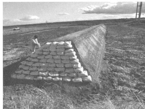
写真-8 施工後の現場の様子 (仙台市若林区藤塚)
