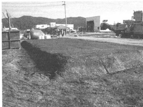
写真-11 地盤沈下した箇所の嵩上げのために造成した人工地盤
