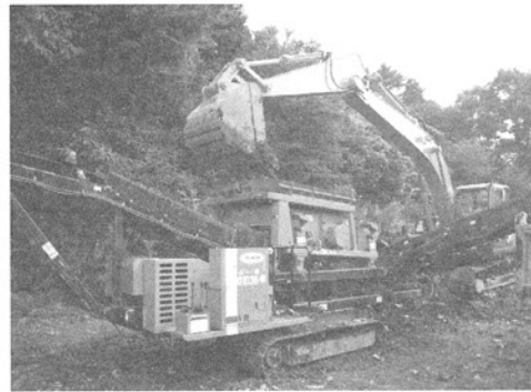
写真-1 作業の外観 (日立建機 VR408(左), 右のパワーショベルは ZAXIS200)
