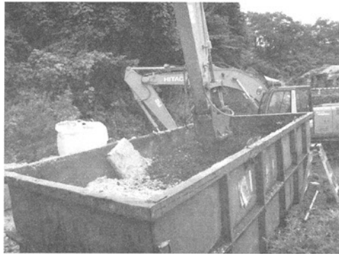
写真-3 古紙破砕物の攪拌・混合
