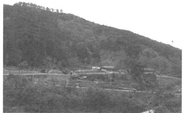
写真-2 深層崩壊が発生した斜面。
