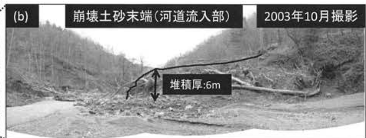
図-3 (a):崩壊土砂の概念図, (b):崩壊土砂末端部の横断面図(北海道開発局 室蘭開発建設部撮影)
