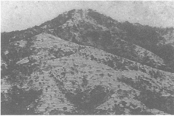
写真-8 階段状に整地された斜面 (写真-6 拡大)
