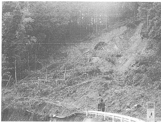
写真-2 09 崩壊例 (no. 1)
