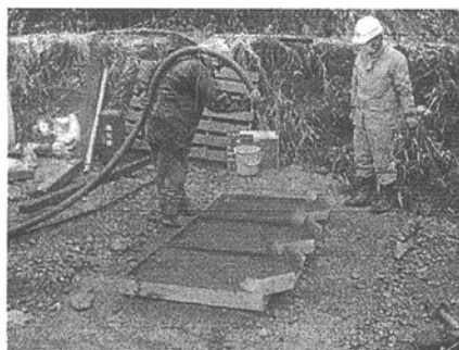
図-4 空気圧縮機を用いて木枠に植生土壌を吹き付けている様子
