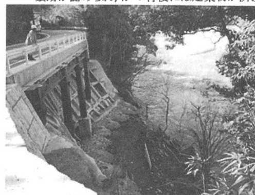
写真-2 一次抽出で抽出された箇所の現地状況の例. 斜面形状から崩壊発生の履歴がある箇所と認められるものの, 現状では既に対策実施済み.
