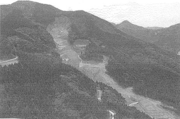
写真-2 朝陣野崩壊地（2009年4月撮影：野尻正太氏）
