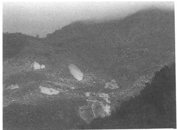
図-8 斜面中部に基岩が露出している様子。ここより上部が約 1km の長さにわたって崩壊した。
