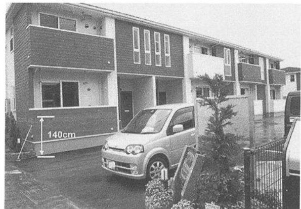
写真1 浸水した新築アパートの状況(7月16日撮影)
