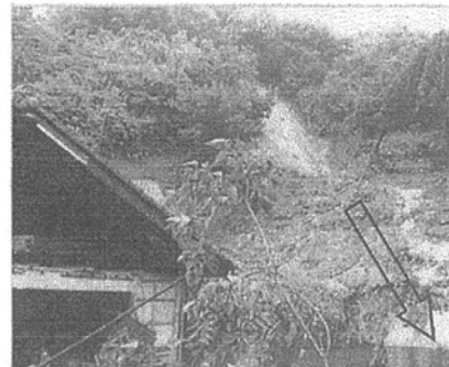
写真-1 霧島市霧島大窪での災害状況(鹿児島県提供)
