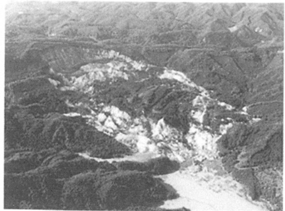
写真-1 荒砥沢地すべり地の様子 (社)東北建設協会提供
