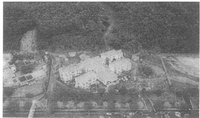
写真-10 「からまつ荘」と裏山の崩壊状況 8)
