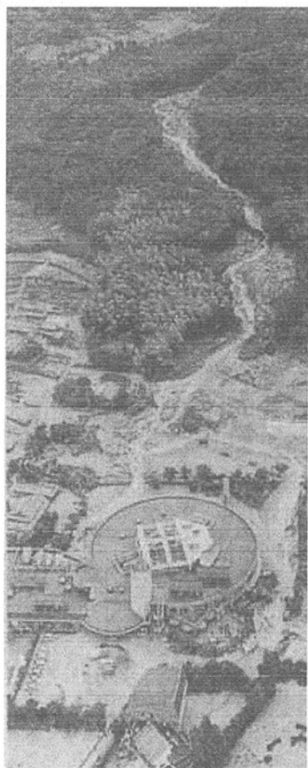
写真-14 被災した老人ホームと土石流の流下跡 1)
