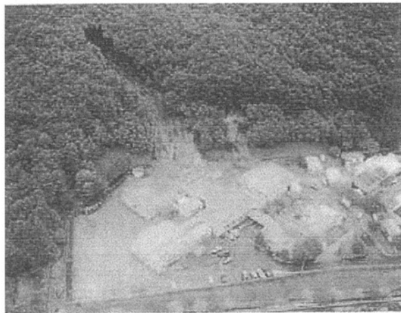
写真-12 「かしわ荘」の裏山の崩壊状況 6)
