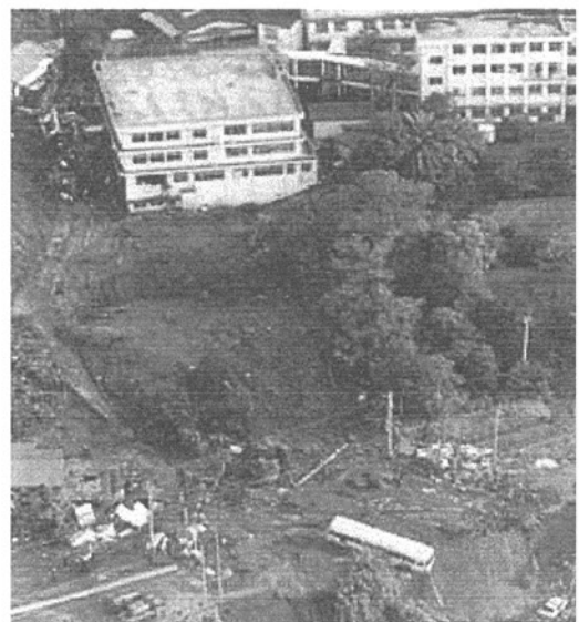
写真-8 花倉病院の災害現場 5)
