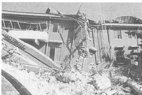
写真-3 押しつぶされた老人ホームの建物 2)
