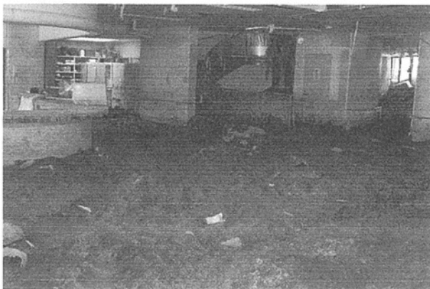
写真-3 老人ホーム内部の土砂堆積
