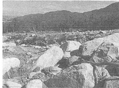
写真-3 石原地区 (No. 3 左岸側より下流を望む)
