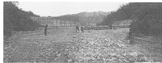
(a) 上流から下流方向の堤体を望む(2009.11.25撮影)
