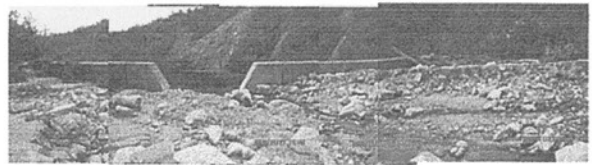
(a) 上流から下流方向の堤体を望む(2009.11.27撮影)
