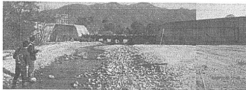
(a) 上流から下流方向の堤体を望む (2009. 11. 25 撮影)
