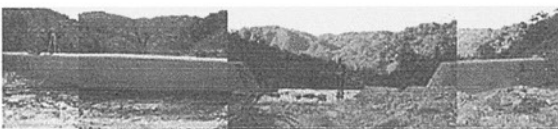
(a) 上流から下流方向の堤体を望む(2009.11.25撮影)
