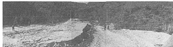
(b) 下流から上流方向を望む(2009.12.8撮影)
