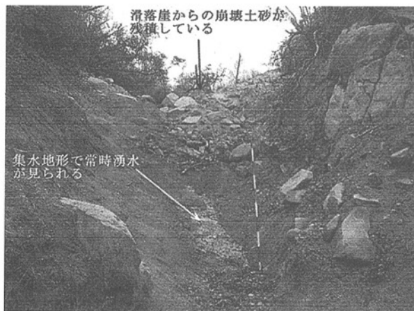
写真-1 崩壊源頭部
