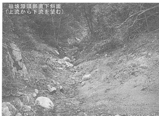
写真-5 崩壊源頭部直下の斜面(上流から下流を望む)
