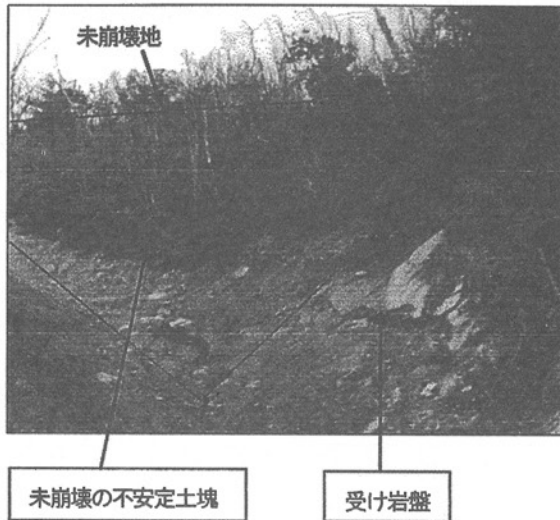
写真-7 未崩壊の不安定土塊写真
