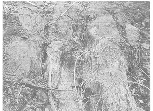
写真-7 土砂と岩盤の境界部にしみ出し程度の湧水あり、湧水箇所はポール先端周辺。
