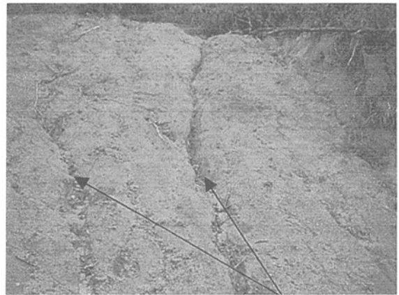
写真-3 崩壊部の上部強風化土砂部に見られる断層 強風化で均等にマサ化している。表流水が浸食して、平滑な断層面は現れている。
