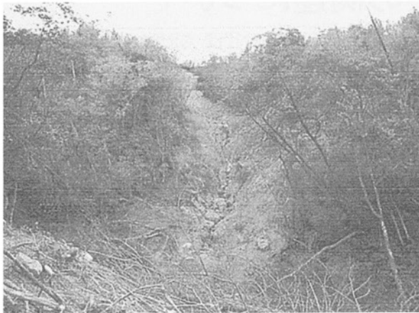
写真-1 崩壊箇所全景
