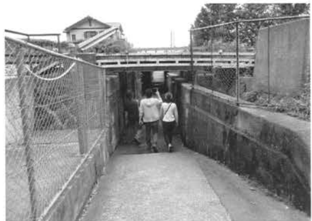
写真-1 線路下のアンダーパス
