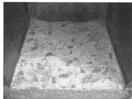
写真-1 チップング処理の状況
