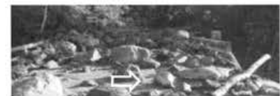
写真-6 丸駒橋上に堆積した土石 B) (手前が右岸側)
