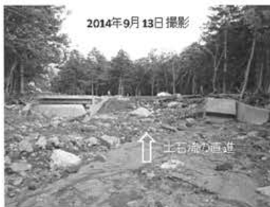
写真-4 丸駒橋右岸側を直進した土石流
