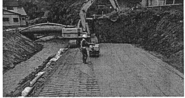
(a) 繊維質固化処理土の転圧
