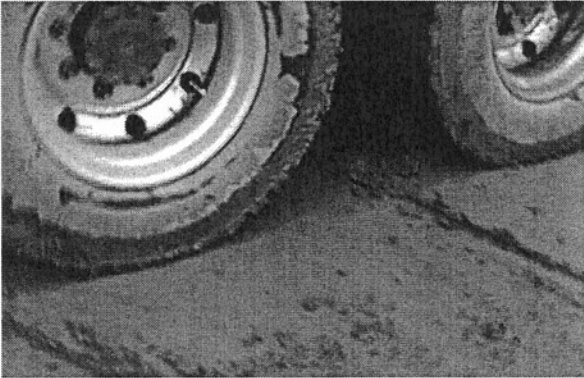
(c) 転圧後、ダンプトラックの進入が可能
