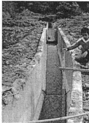
写真1 小谷集落の流路工
