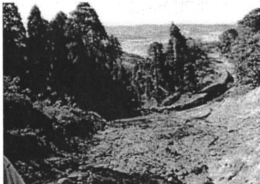
写真8 崩壊土砂が谷に流れ込み土石流を誘発
