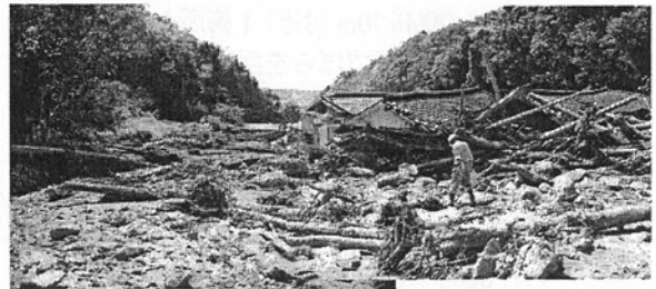
写真-5 被災現場（新御堂地区）
