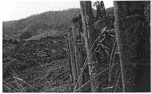
写真-8 抑止杭工(2004/11/27)
