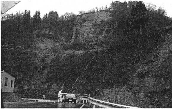
写真-1 表層崩壊 (2004/11/27)
