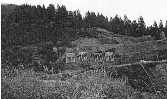
写真-7 雪崩防止柵工(2004/11/27)
