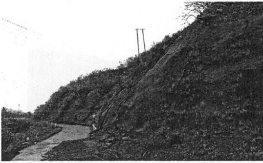
写真-4 吹付け工(2004/11/27)
