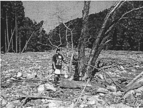
写真-5 土砂堆積の状況 (流路B) (流路中央から下流方向を望む)
