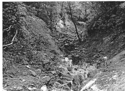
写真-3 春井手川で発生した土石流の河道侵食の状況(下流から上流方向を望む)
