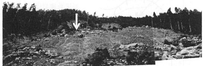
写真-2 土石流発生翌日の崩壊地内の湧水（↓）
