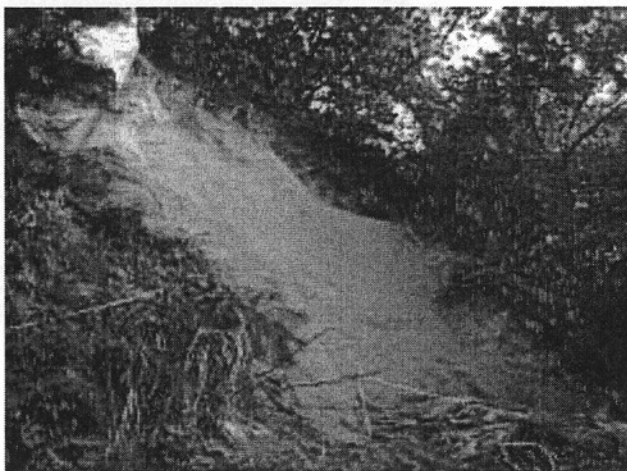
写真-8 志賀島中央北側に位置する勝馬地区の崩壊
