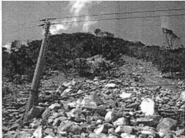
写真-5 志賀島東側の崩壊3
