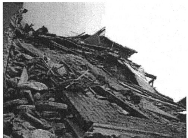
写真-1 宅地崩壊(久保田撮影, 以下, 明記無しは同じ)
