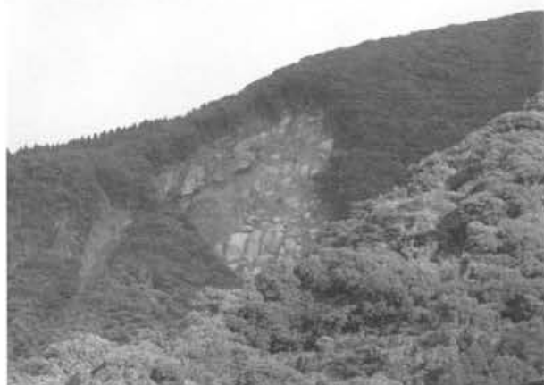
写真-2 土石流区間に見られる厚層風化帯
