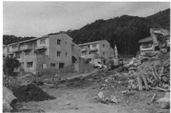
写真-1 被災した県営住宅の写真(下流から上流側を臨む。2014年9月撮影)
