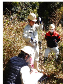
写真-2 測定状況
