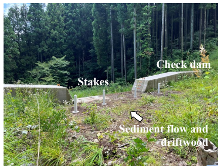
図-15 あと施工流木捕捉工の設置事例（上：隣接する林道から撮影，下：堆砂域から設置後に撮影）
