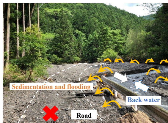
図-1 土砂・洪水氾濫の被災状況 (R4 台風15号, 大井川支流)
