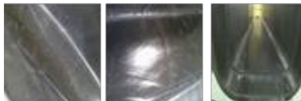
図-3 下流側の 3 方向から U 字溝を撮影した写真
