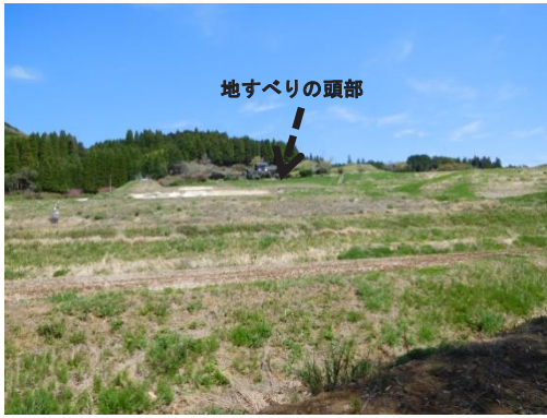
写真-2 下方からの全景（撮影日：2023. 4. 9）
