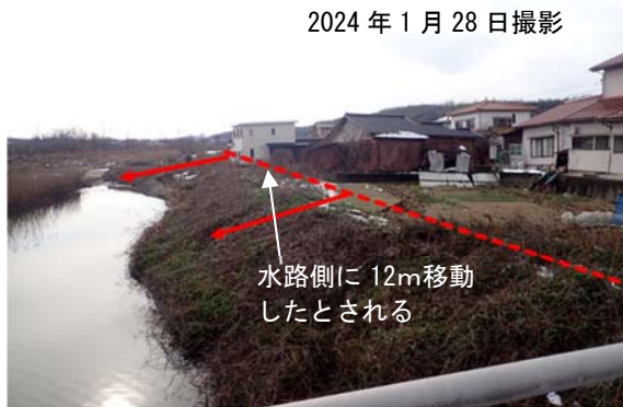
写真-1 西荒屋～室間の液状化・側方流動
