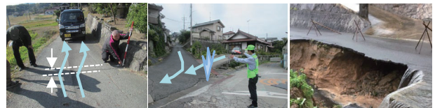
避難時に水深約10cm 水が流下し樹から噴水 道路が河川侵食
