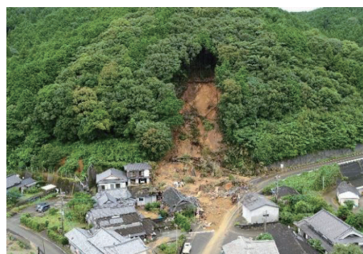
図-6 崩壊時刻が実測された斜面崩壊
