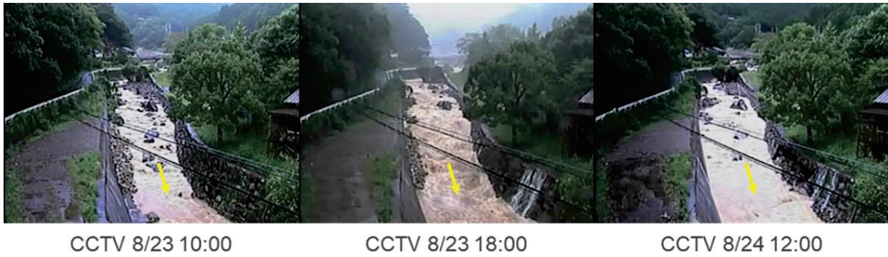
写真-2 平成30年台風第20号時の熊野川におけるカメラ画像
