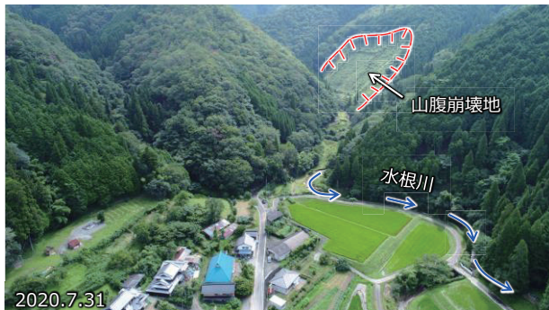
図-2 H21.8 (2009) 豪雨による山腹崩壊地
