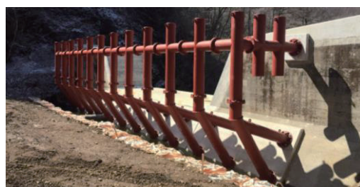
写真-1 張り出しタイプ流木捕捉工
