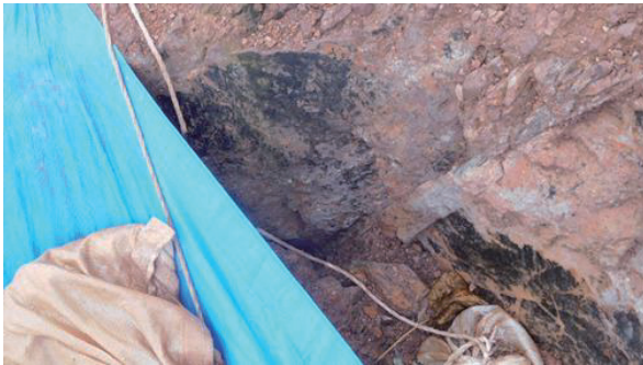
写真-2 クラック面にみられた光沢質黒色薄層土
