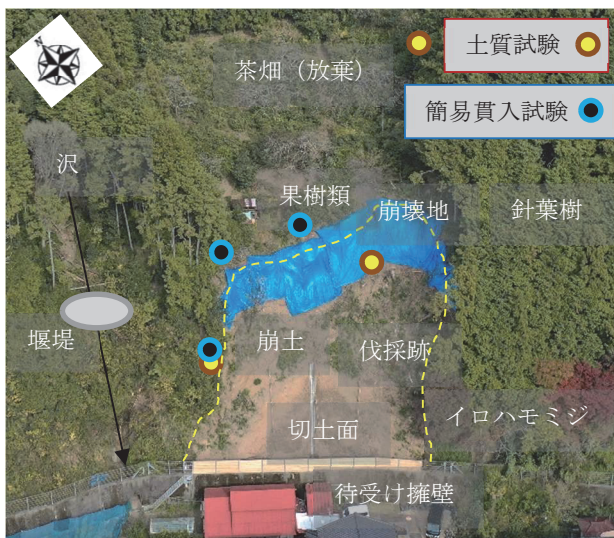
図-2 B 地区概要 (崩土撤去後)
