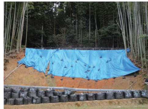
写真-1 道路斜面の崩壊（北九州市）
